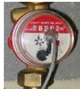
Figuur 4. volumetrische debietmeter
